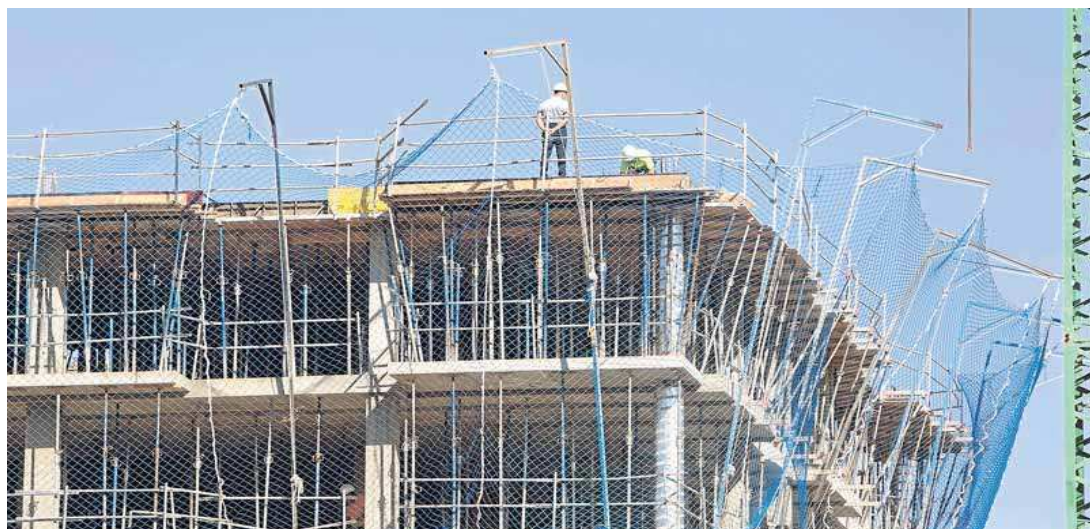
Edificio en construcción en Valencia. :: DAMIÁN TORRES
