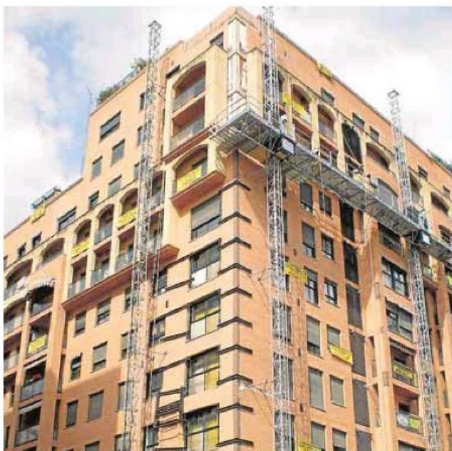
Edificio en obras. | P
