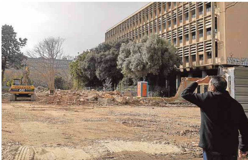
Aspecto de las obras de ampliación del Hospital Clínico. IVÁN ARLANDIS
