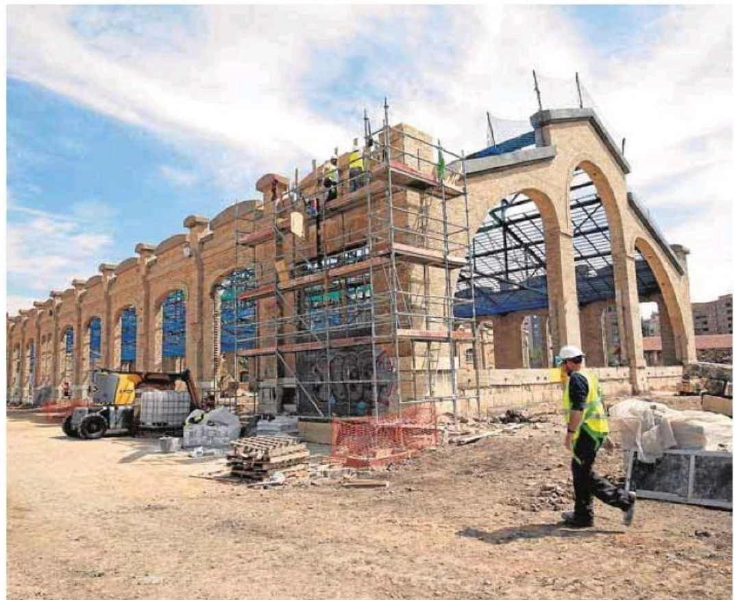
Obras de rehabilitación en una imagen de archivo. :: I. MARSILLA
